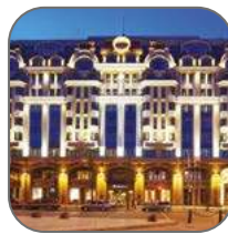
Защита высотных домов и гостиничных комплексов
