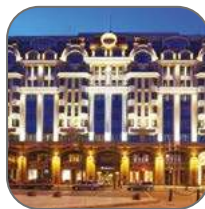
Защита высотных домов и гостиничных комплексов
