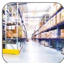
Производственные и складские помещения
