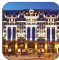
Защита высотных домов и гостиничных комплексов
