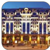
Защита высотных домов и гостиничных комплексов
