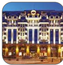
Защита высотных домов и гостиничных комплексов
